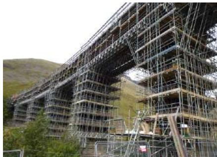
Auch Viaduct, Tyndrum
